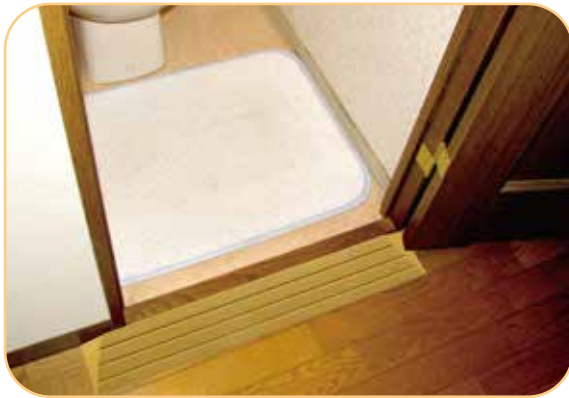
廊下とトイレの段差に!
